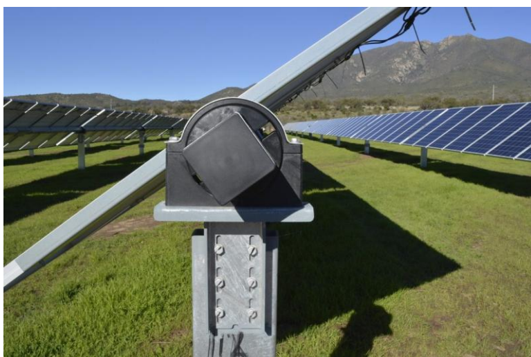
Figura 17 Dettaglio del tracker ad inseguimento
